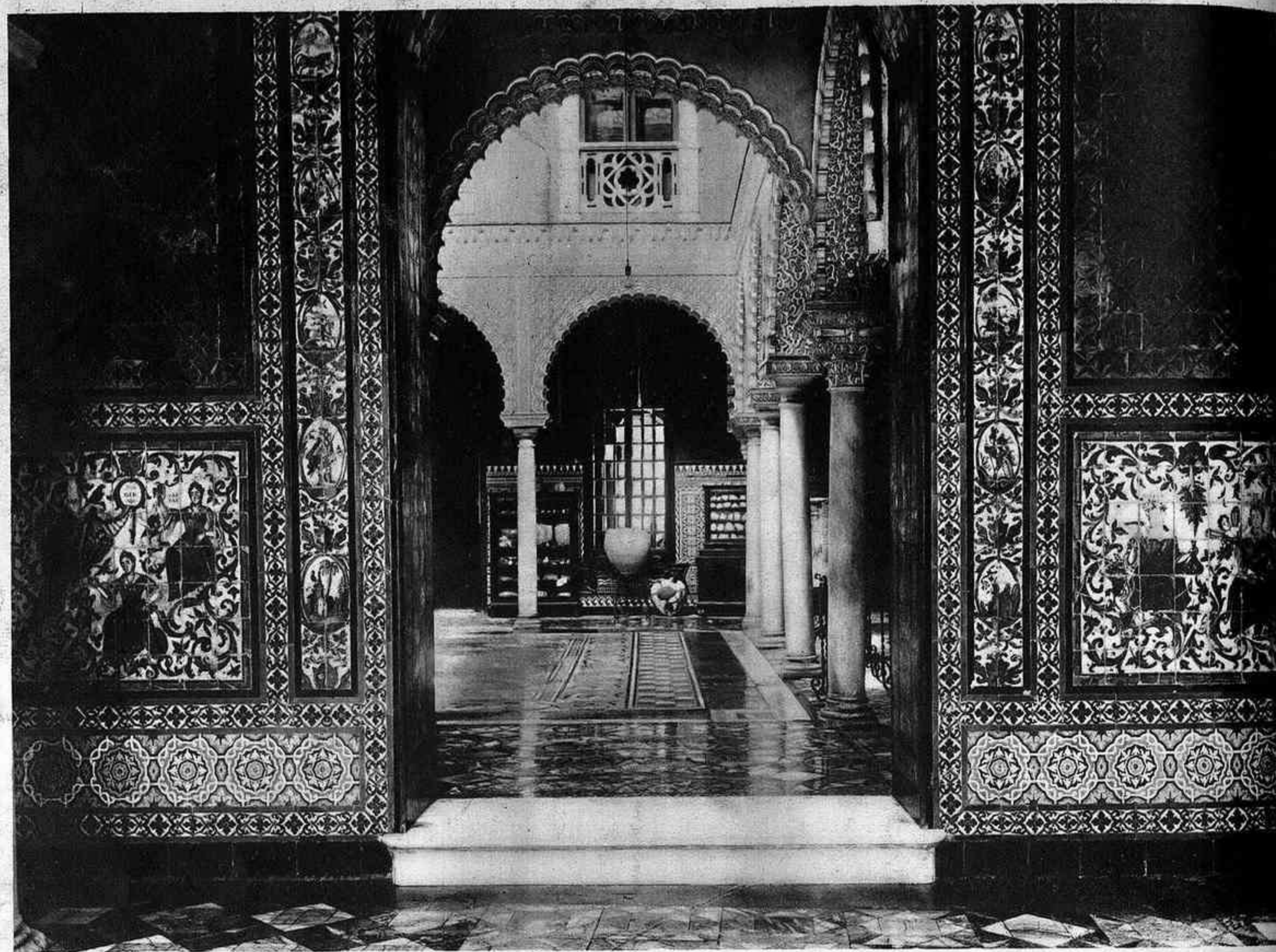
Aspecto del patio del palacio de la condesa de Lebrija, visto desde la cancela de entrada
