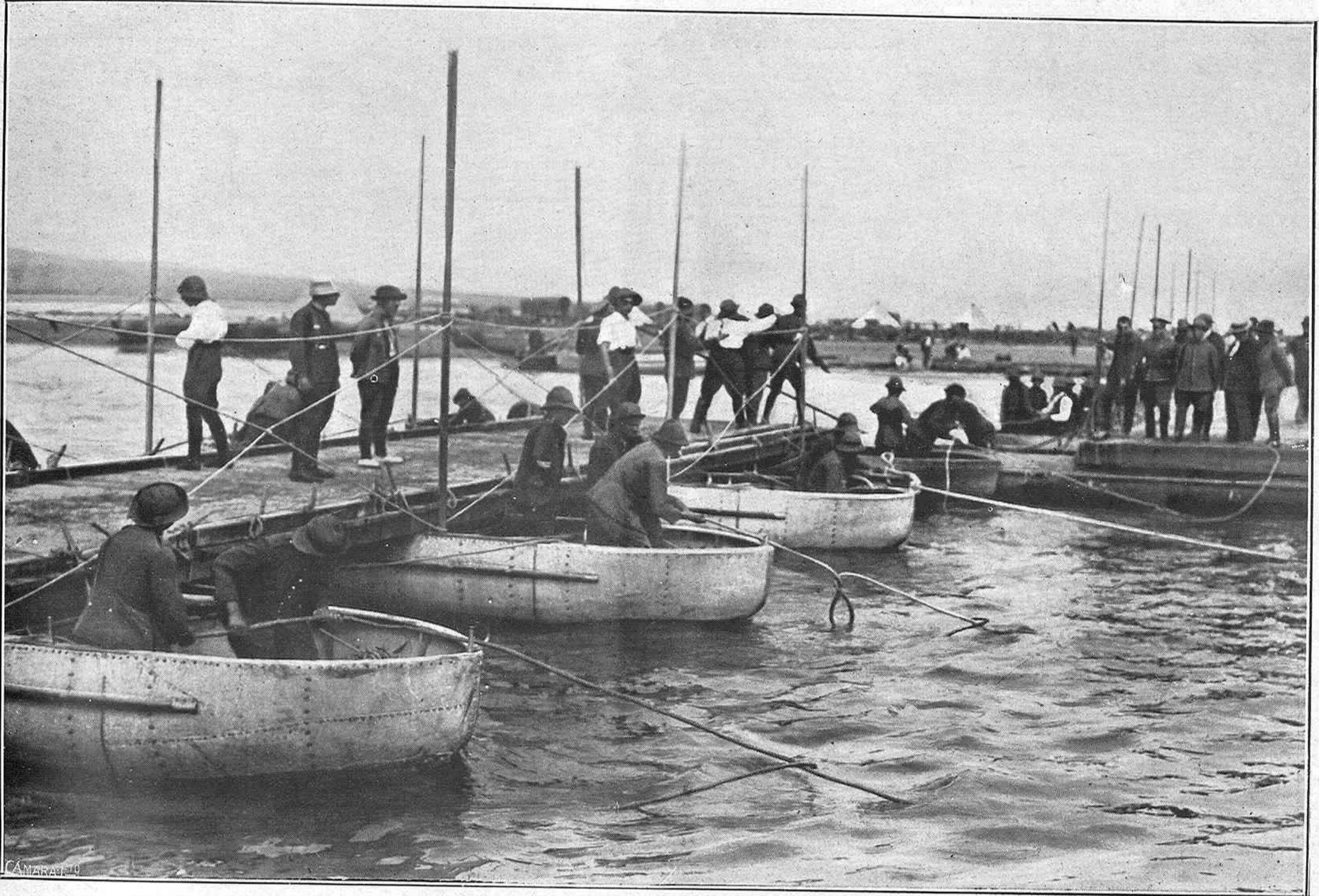
Ingenieros militares tendiendo un puente sobre barcazas, en la bocana de Mar Chica, para facilitar el paso de los convoyes á la Restinga FOT. CAMPÚA
