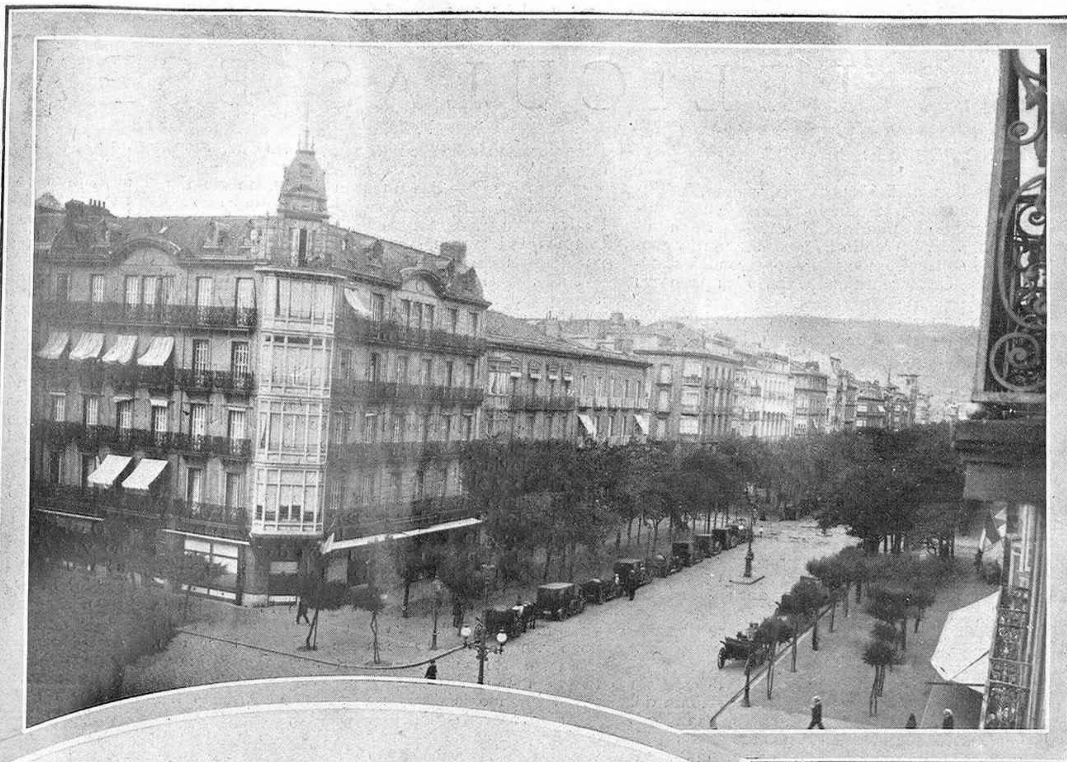
Avenida de la Libertad
