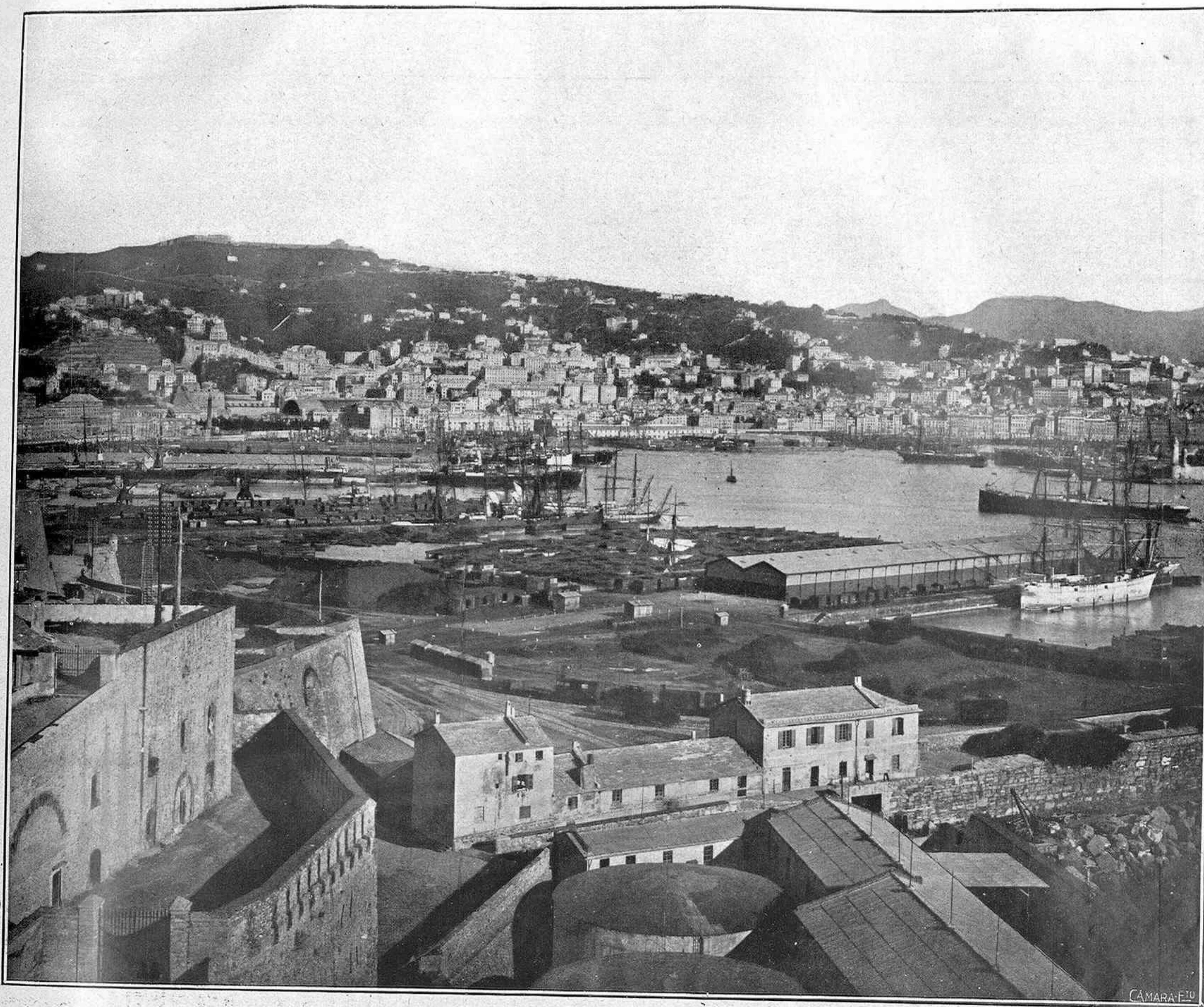
Un trozo del puerto desde "La Linterna" ó Faro de Génova. En el fondo, el Monte Righi
