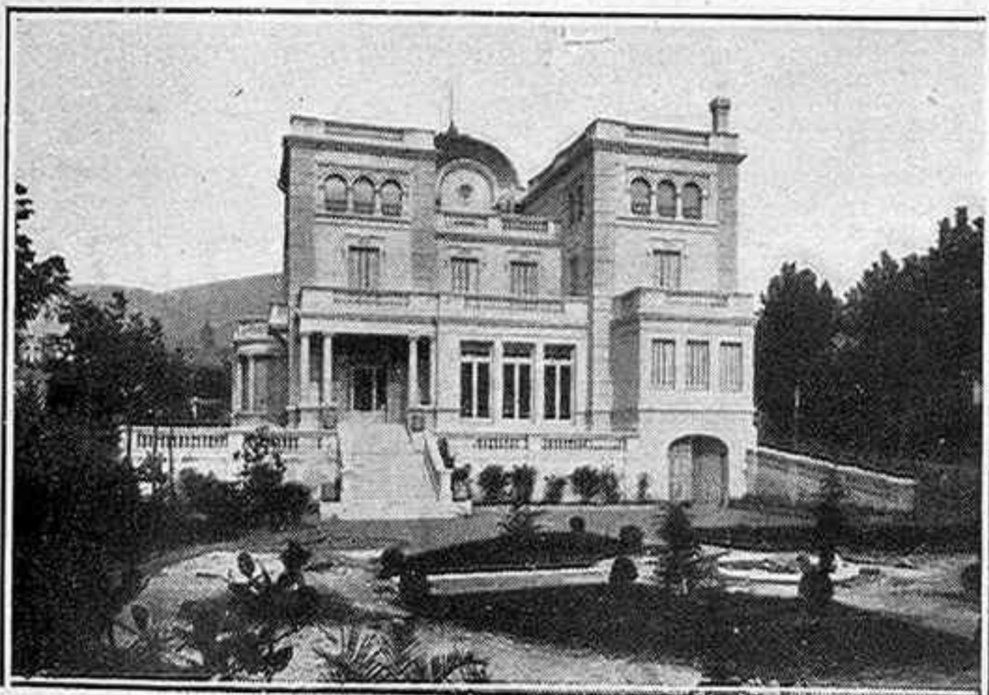
Fachada posterior del edificio propiedad del Sr. Marqués de Foronda.—Contratistas: Sres. Pujadas y Llobet
