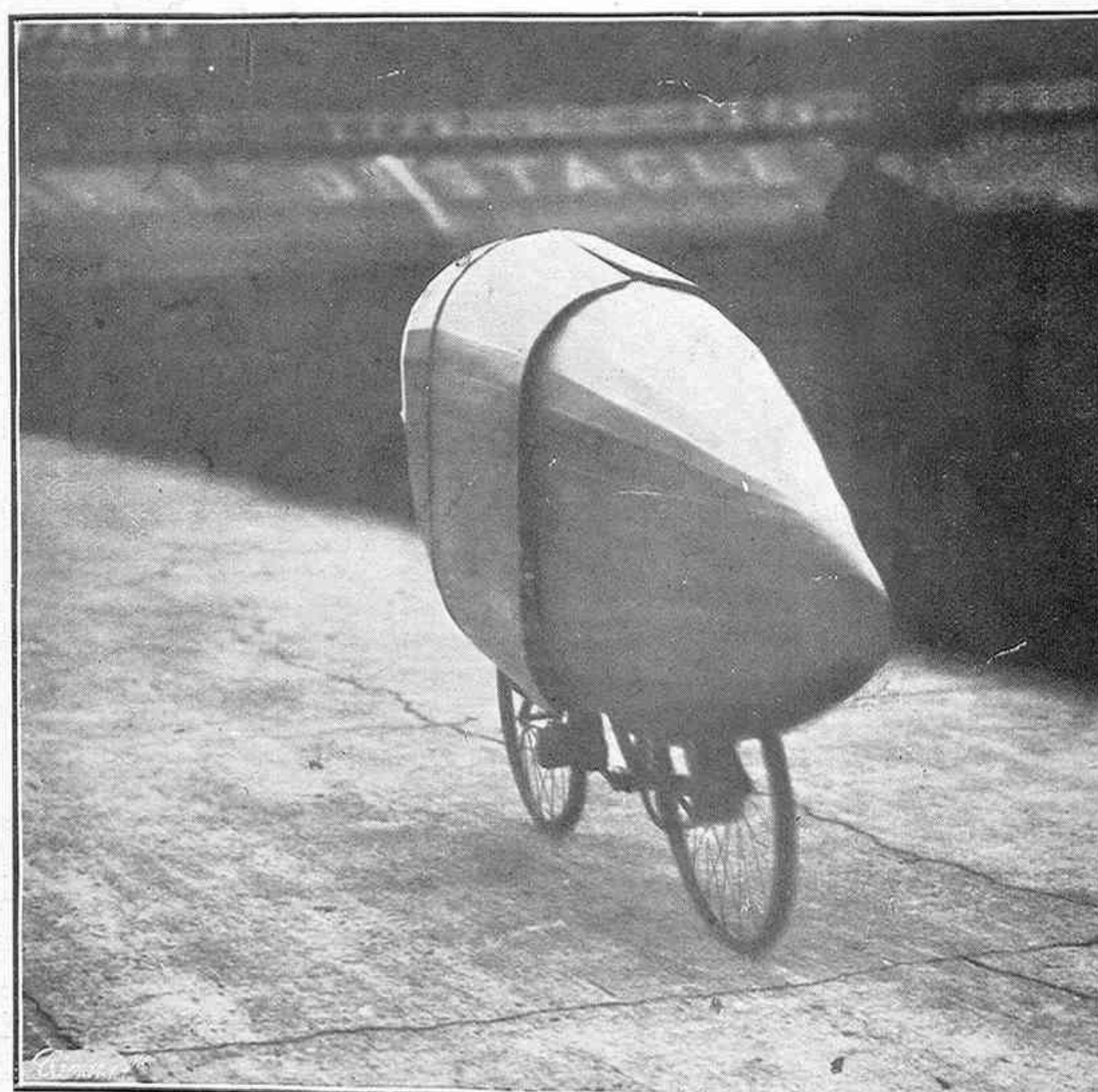
El velo-torpedo Bunau-Varilla adaptado á una bicicleta y con el que se han hecho pruebas en París con excelente resultado, pues evita al corredor la molestia del aire y le permite hacer mayores velocidades
