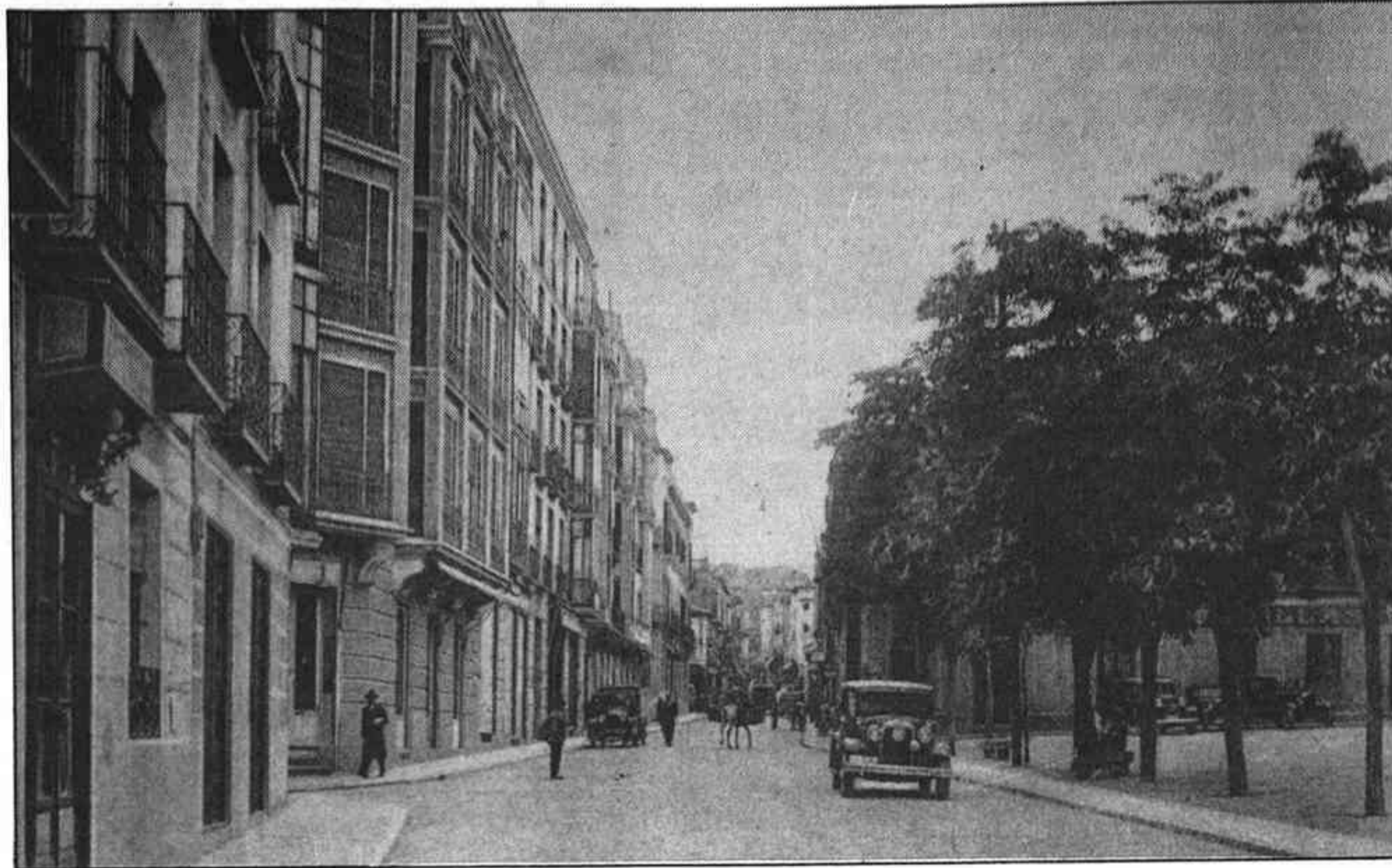
Fotografía del tramo bajo de la calle Miguel Fluiters, a la altura de la Plaza de los Caídos. Como se puede apreciar, la calzada se la repartían los viejos Ford y los paisanos con caballerías
