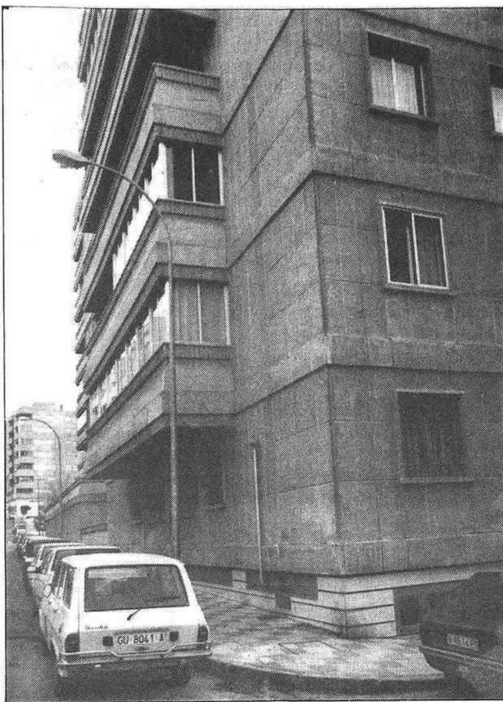
Imagen del edificio afectado y alcantarilla por la que se vertió sólo una pequeña cantidad del combustible
