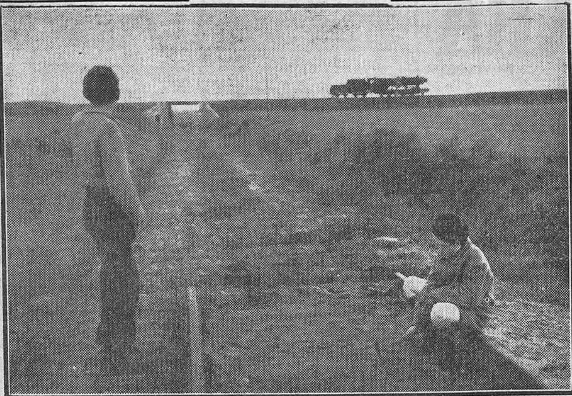
En su afán de expulsar de Berlín a las occidentales, los rusos no han escatimado medios para impedirles el acceso a la ciudad, destruyendo para ello las vías férreas en decenas de kilómetros. He aquí lo que queda de una línea ferroviaria de las que unían Berlín con los puertos del Norte
