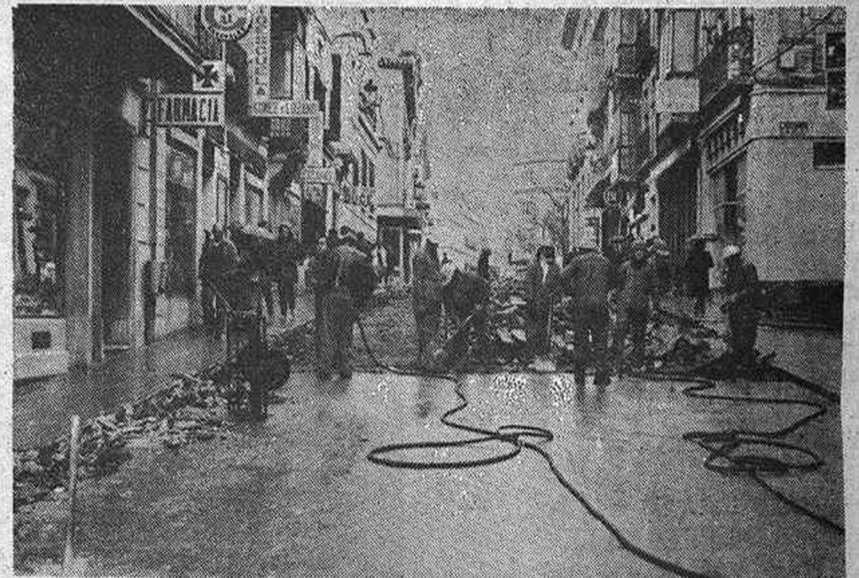
Las obras de peatonalización de la Calle Mayor, iniciadas con polémica en 1984, prosiguieron durante todo este año.
