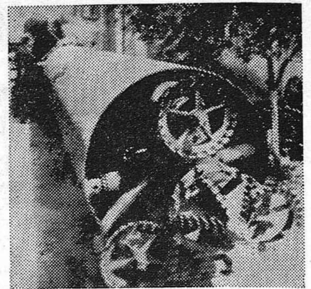
Una nueva perforadora de roca ha sido diseñada por el ingeniero I. Isken-dérov, de la república de Azerbaidzhán, en la URSS. Permitirá instalar tuberías en terrenos rocosos, bajo los terraplenes de las vías férreas, en la construcción de gaseoductos y tomas de agua. Una de sus cabezas se acopla a un tractor, mientras que en la otra se encuentran las cuchillas que excavarán el suelo, por duro que éste sea.
