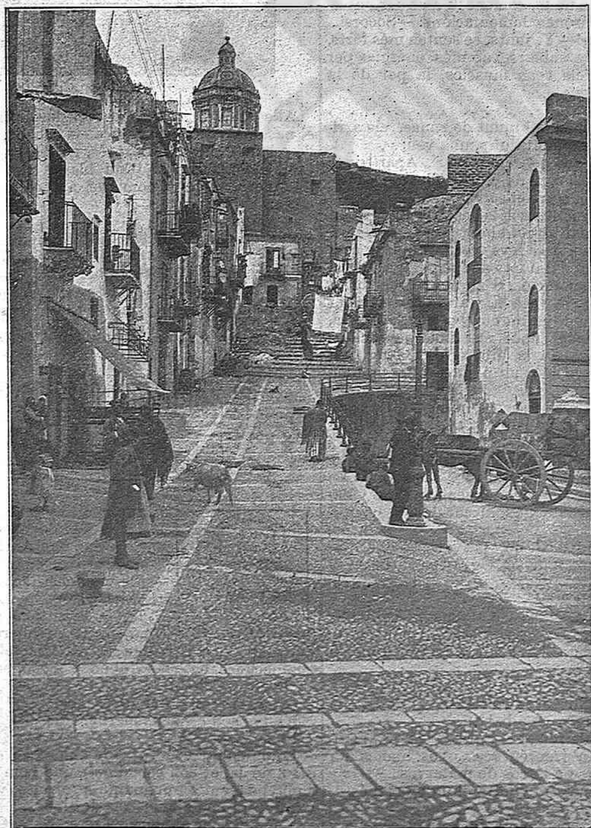
Un carrer de Mineo, població que se suposa completament destruïda.
