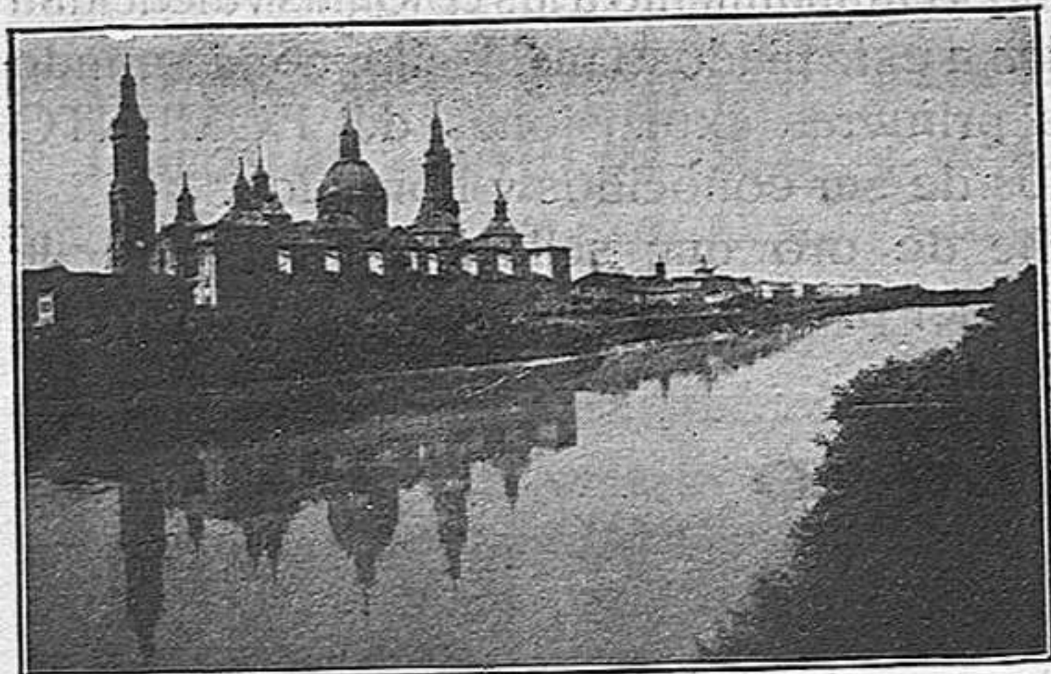
ZARAGOZA.—Basilica del Pilar
