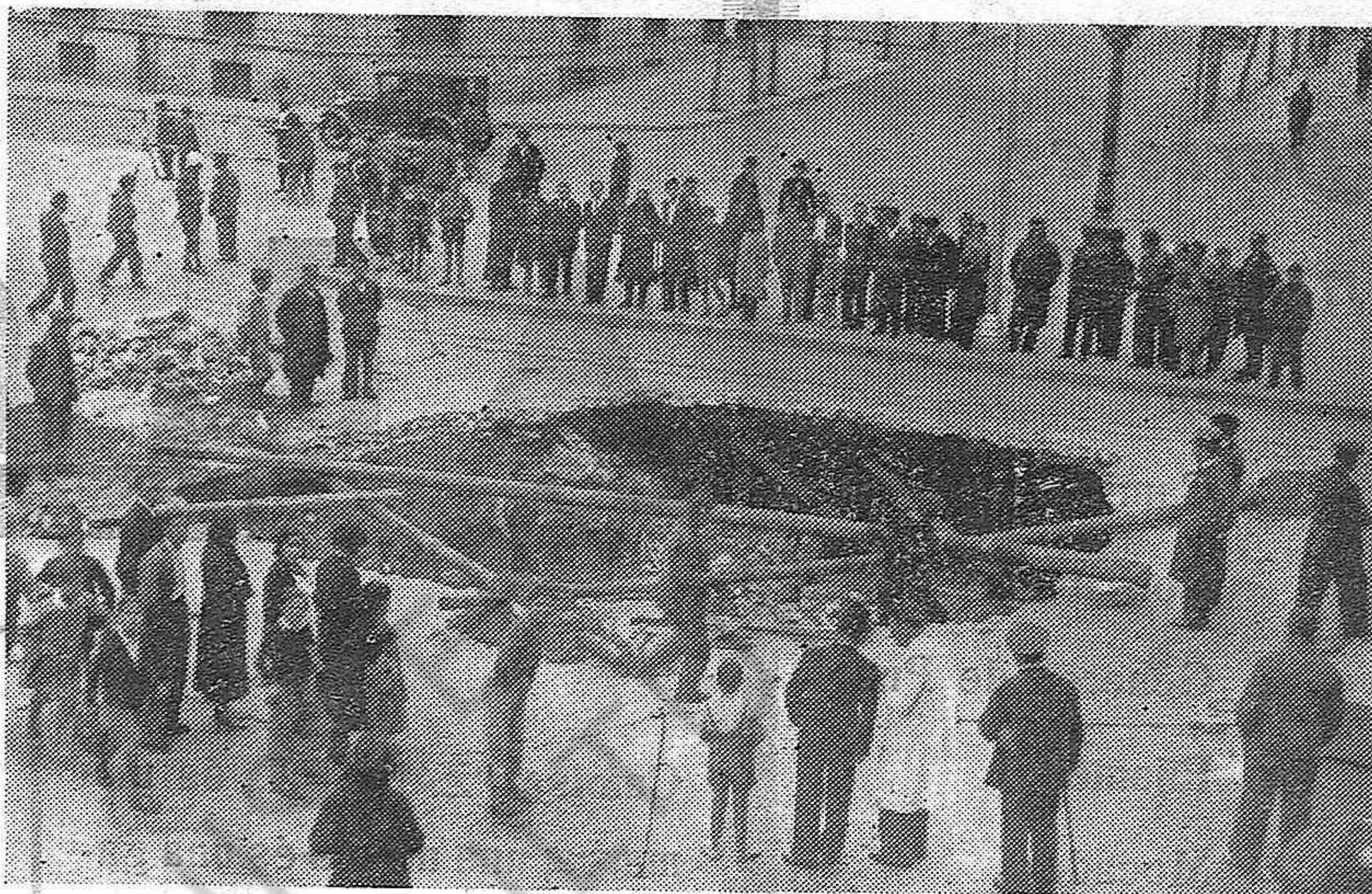
En la calle de Alberto Aguilera, de Madrid, se ha producido el hundimiento de un trozo de la misma. El público contemplando el trozo siniestrado.
