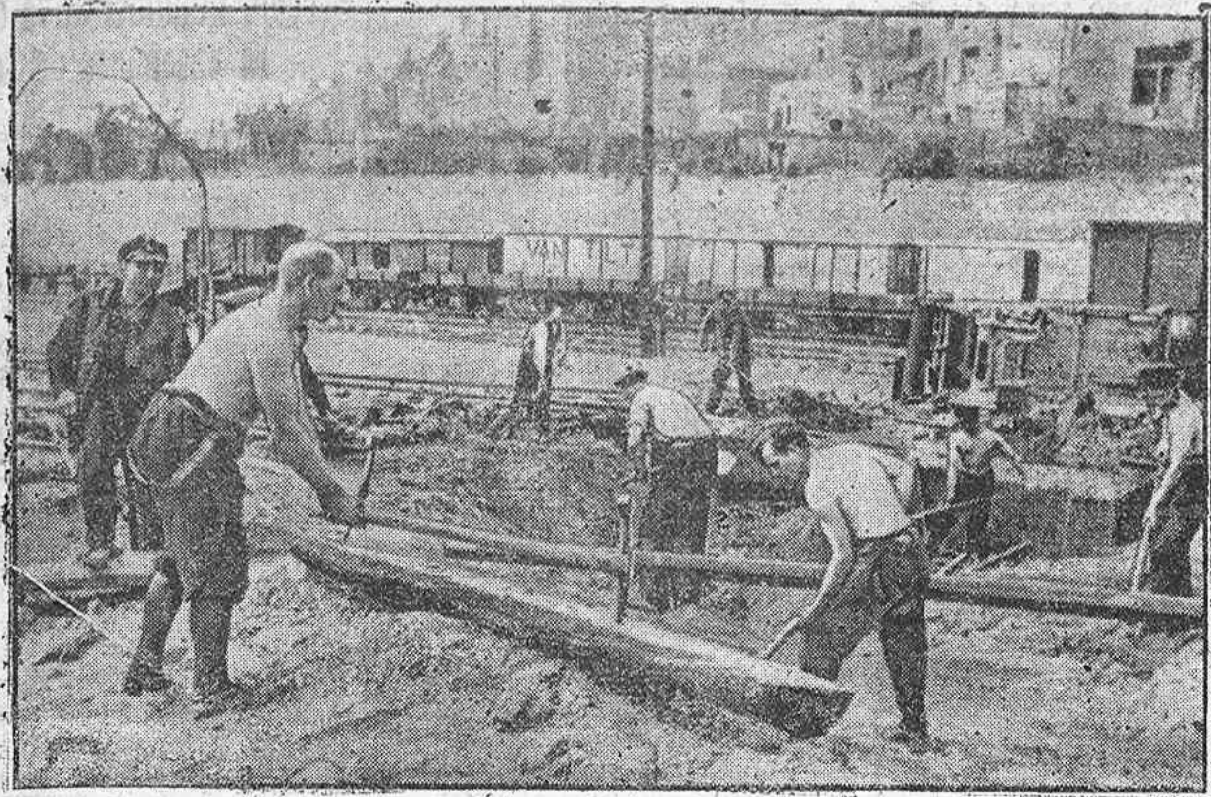
Sección de zapadores ferroviarios alemanes ocupados en la reconstrucción de las comunicaciones francesas
