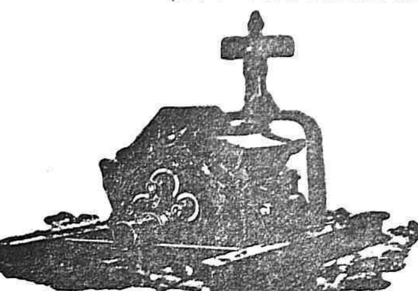
Nuevo aparato perfeccionado para extraer agua, aprovechando los excedentes hasta la última gota del líquido, y con el más pequeño esfuerzo de las caballerías, por la disposición de la araña y por la suavidad de los rozamientos montados sobre armadura de cilindros.
