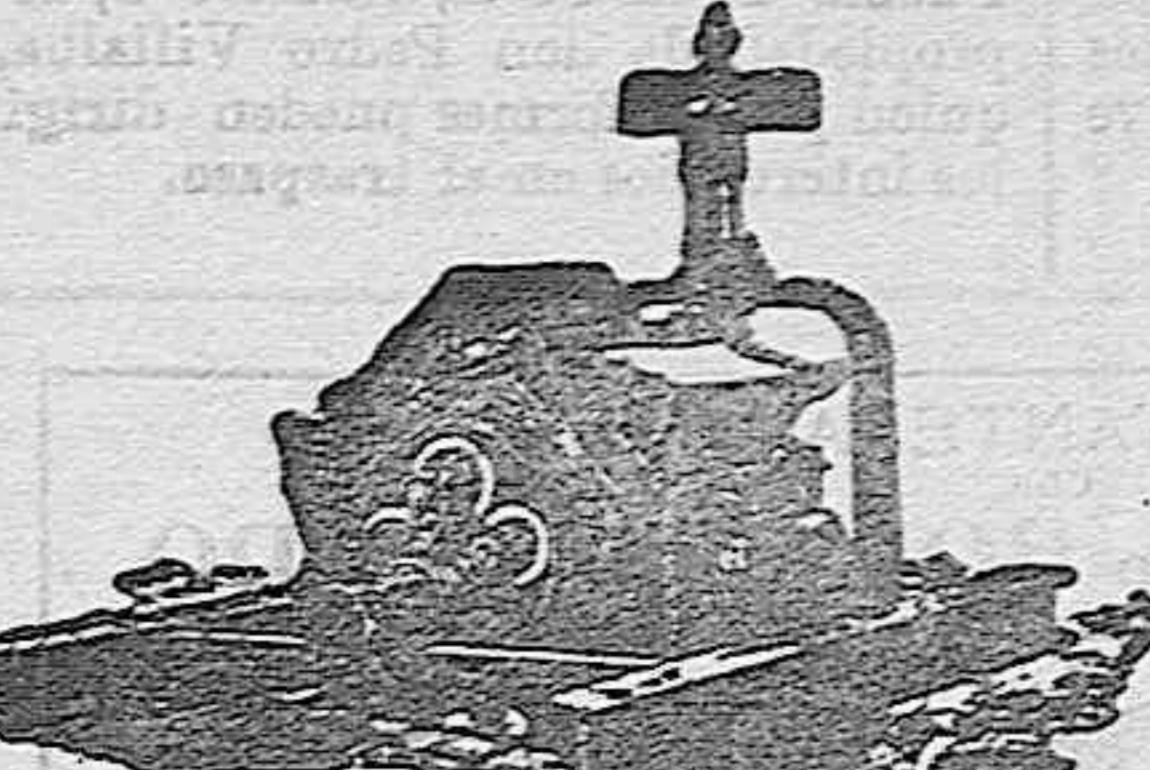
Nuevo aparato perfeccionado para extraer agua, aprovechando los residuos hasta la última gota del líquido, y son el más pequeño esfuerzo de las caballerías, por la disposición de la artesa y por la suavidad de los rodamientos montados sobre armadura de sillín.
