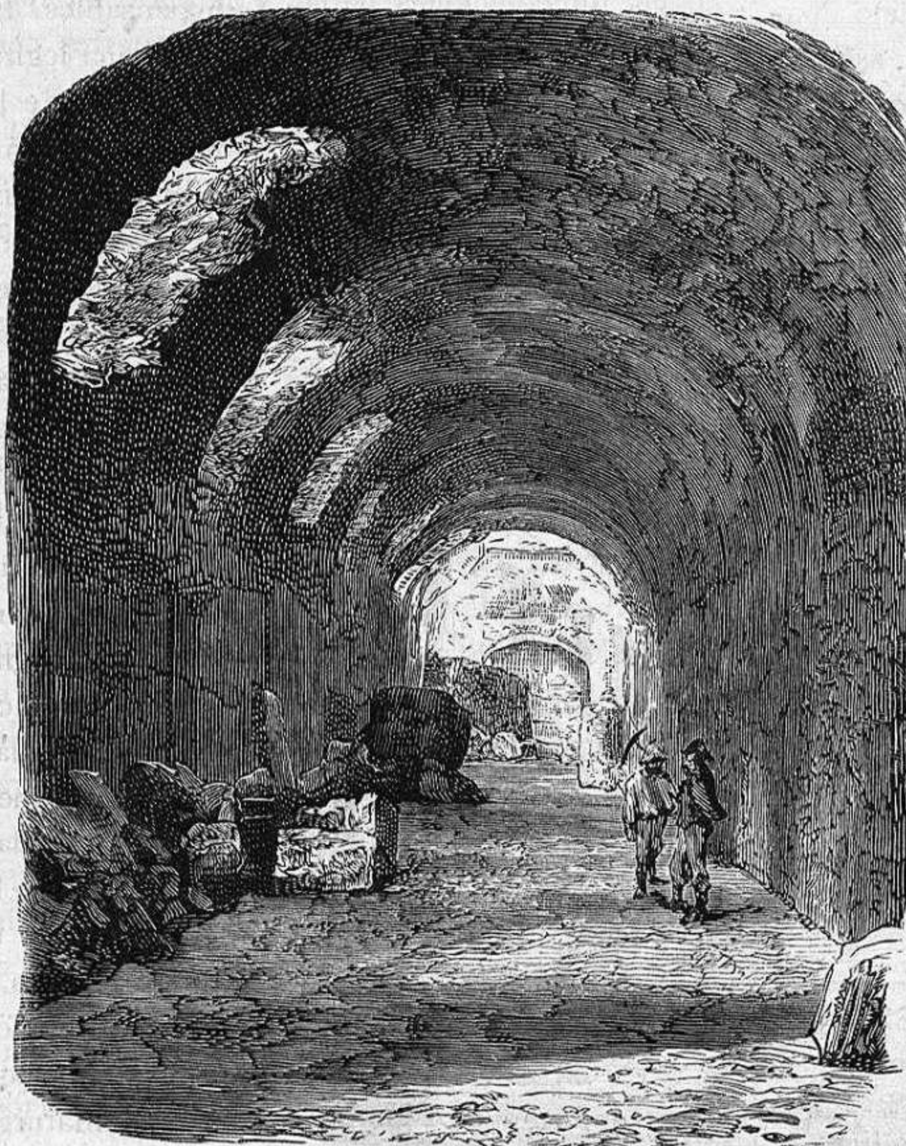
SUBTERRÁNEO QUE PONIA EN COMUNICACION LA CASA DE LIVIA CON EL PALACIO DE AUGUSTO.
