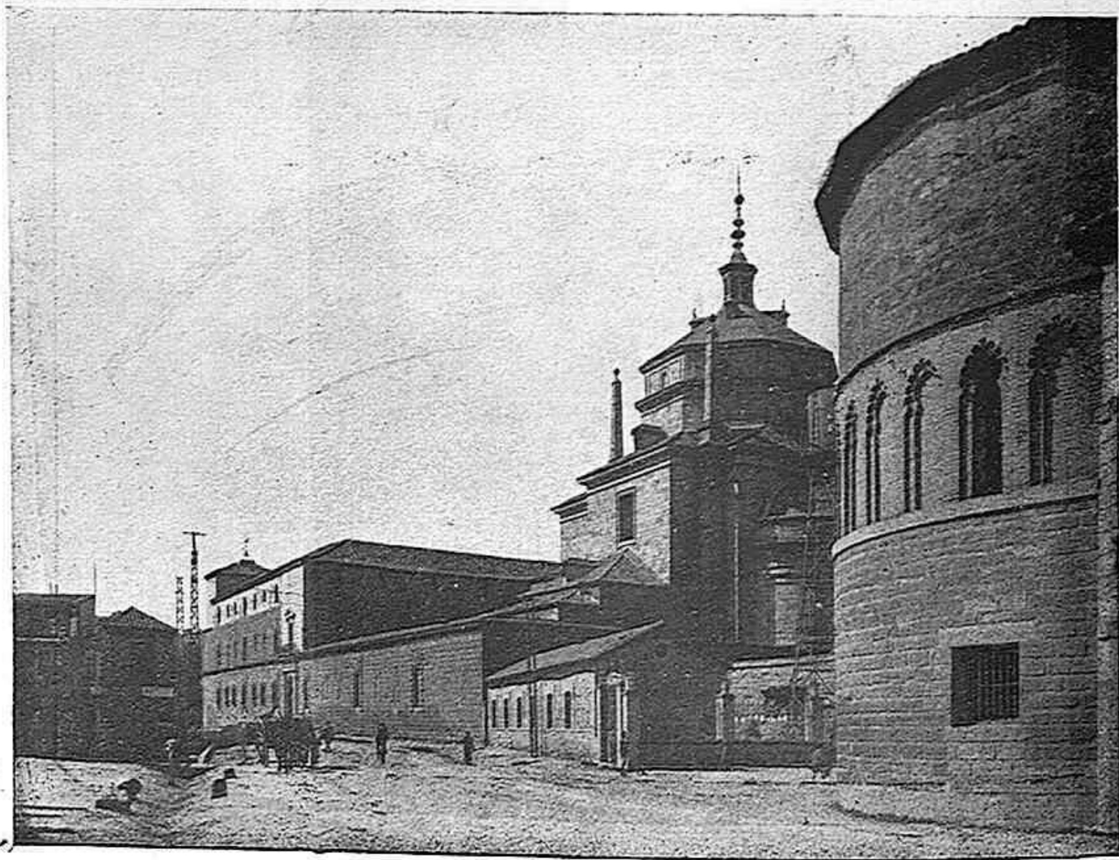
LA CARRETERA DE MADRID, EN SU ENTRADA EN TOLEDO
