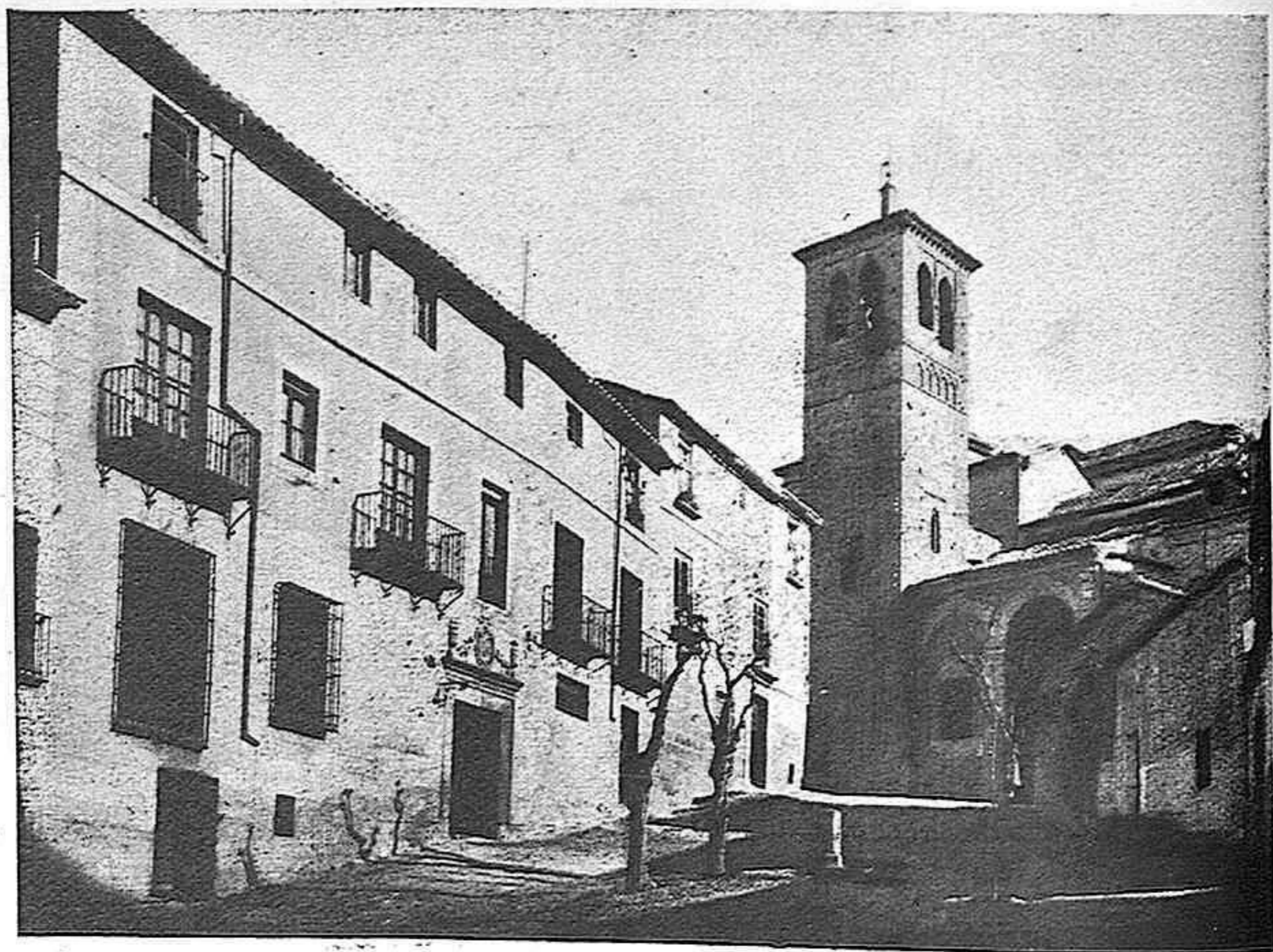
FACHADA DE LA HOSPEDERÍA
