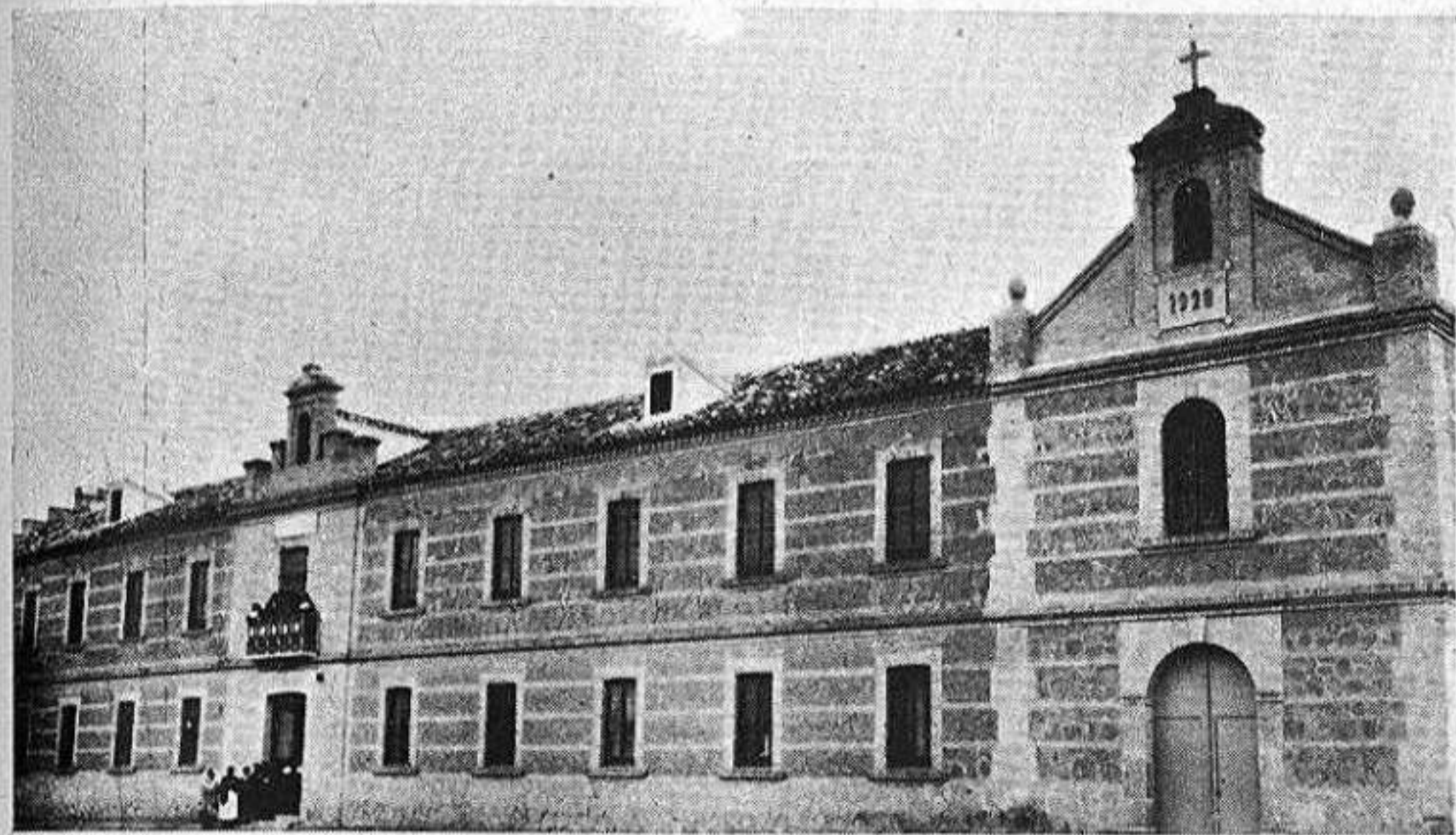
EXTERIOR DEL ASILO DE ANCIANOS EN QUINTANAR DE LA ORDEN, MARAVILLOSA INSTITUCIÓN QUE HONRA AL PUEBLO Y PREGONA SU ALTRUISMO Y SU CULTURA
