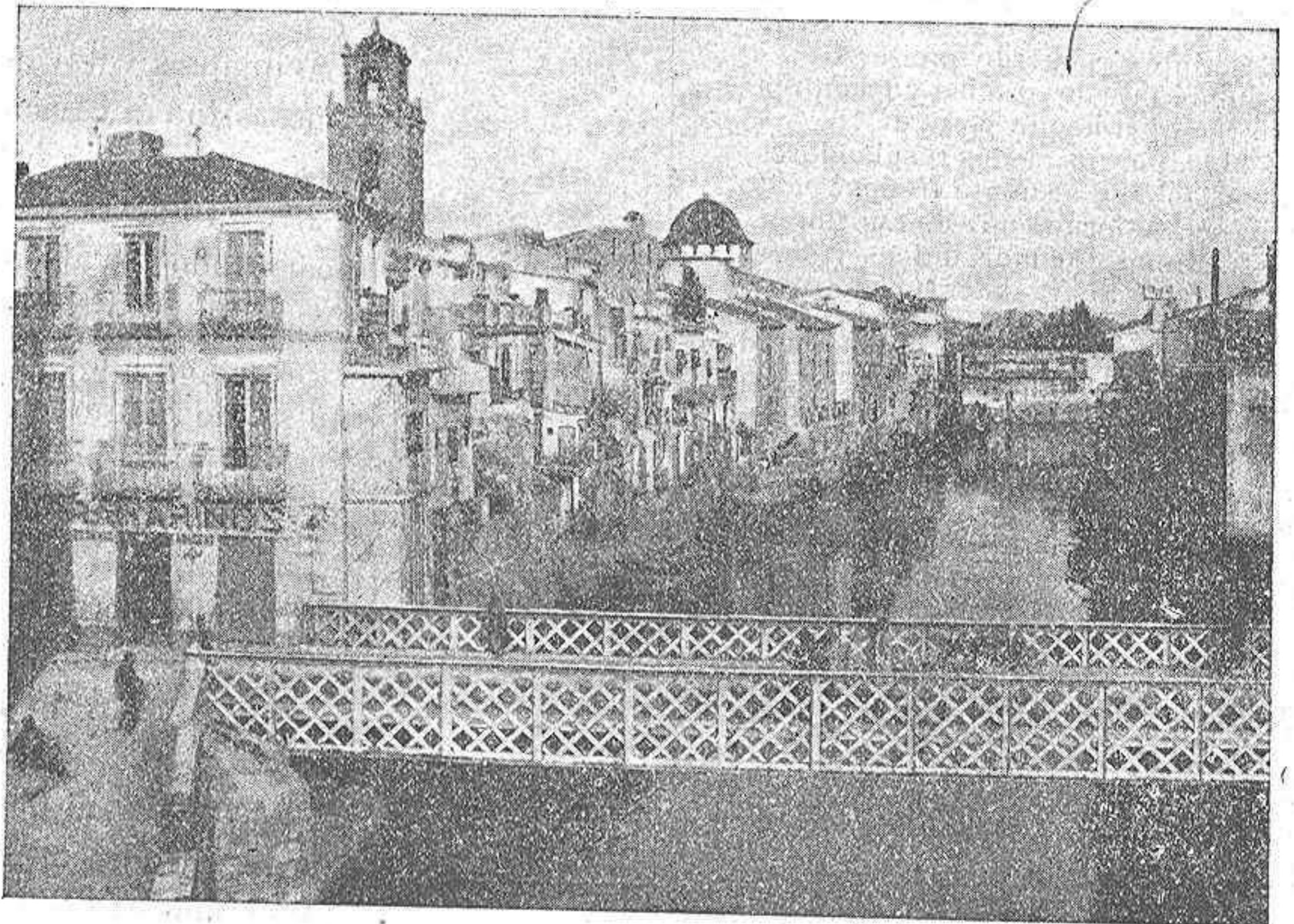
Orihuela.—Vista del puente de Poniente. Fot. de S. Parra.
