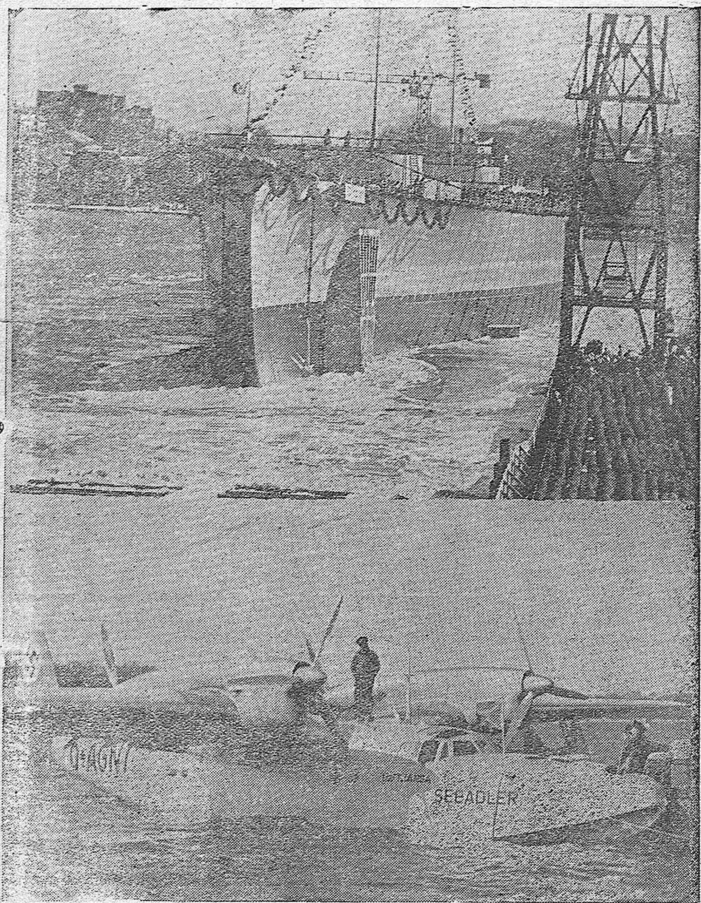
La botadura del acorazado alemán «Tirpitz» de 35.000 toneladas, en presencia del Fuhrer y 80.000 espectadores en la ciudad de Wilhelmshaven.—El último tipo de hidroavión para vuelos transoceánicos de la Lufthansa. Lleva cuatro motores y alcanza una velocidad media de 800 kilómetros por hora, con un radio de acción de 9.000 kilómetros.
