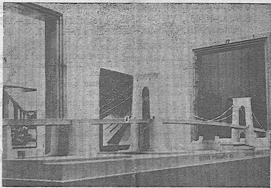
MODELO DEL PUENTE DE SUSPENSION DE HAMBURGO, PROYECTADO SOBRE EL RIO ELBE. EL PUENTE TENDRA UNA ALTURA DE PASO DE 80 METROS, Y UNA ANCHURA DE 700 METROS. LA ALTURA DE LAS PILAS ES DE 177 METROS Y LA ANCHURA DEL TABLERO DEL PUENTE, DE 22
