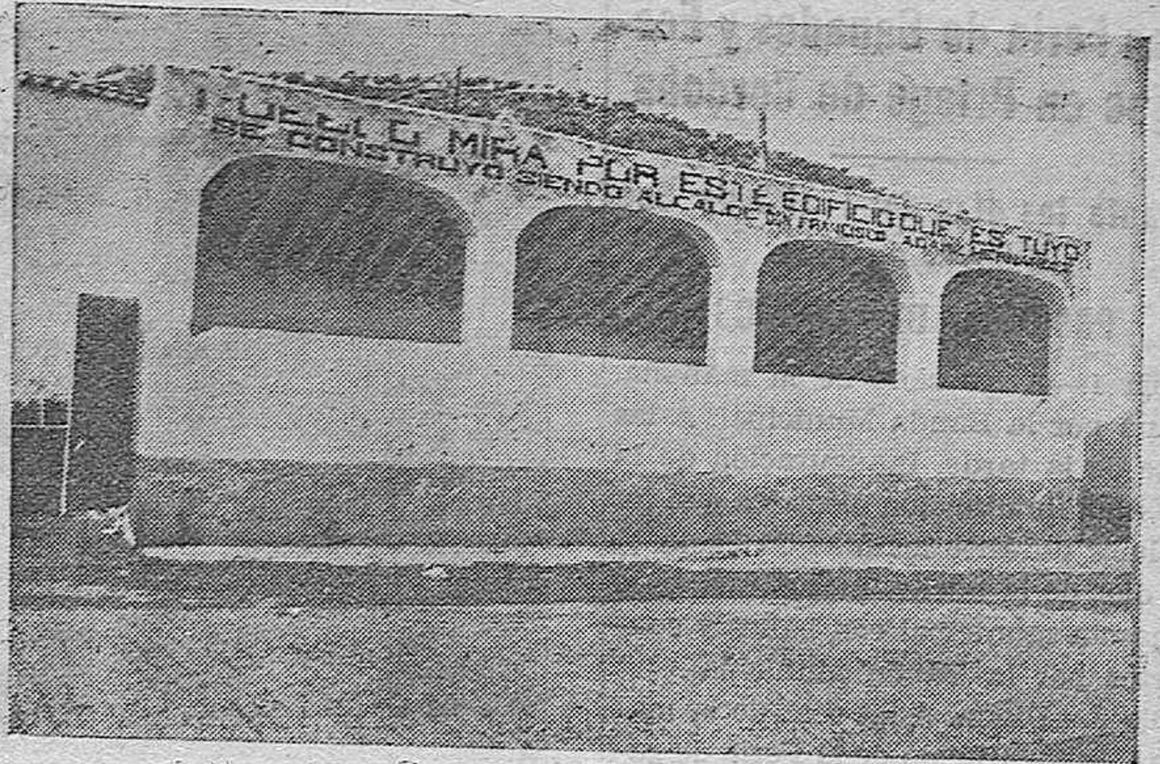
PRIEGO DE CORDOBA.—Lavadero construido en la calle Feria (Foto Angel)
