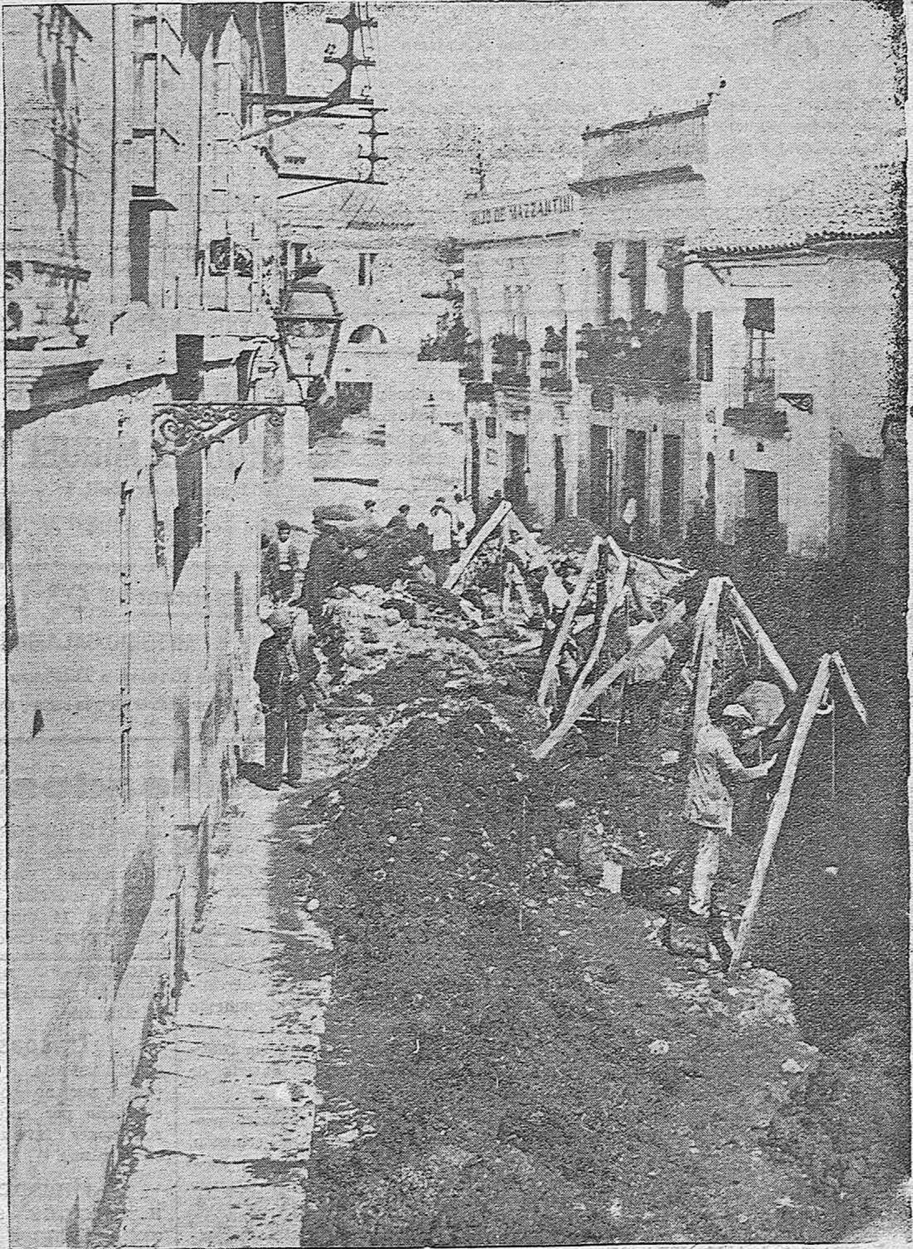
EL MEJORAMIENTO DE LA CIUDAD. Aspecto de la calle de Alfaro, cuyas obras de alcantarillado se hallan en plena actividad, y en las que trabajan numerosos obreros.
