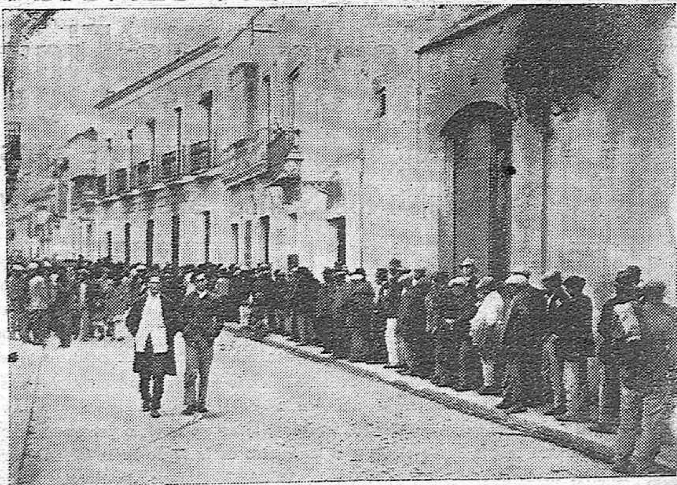
EL PROBLEMA DEL HAMBRE.—Cola de obreros que en la Plaza de San Andrés esperaban hoy turno para comer en la Cocina Económica.
