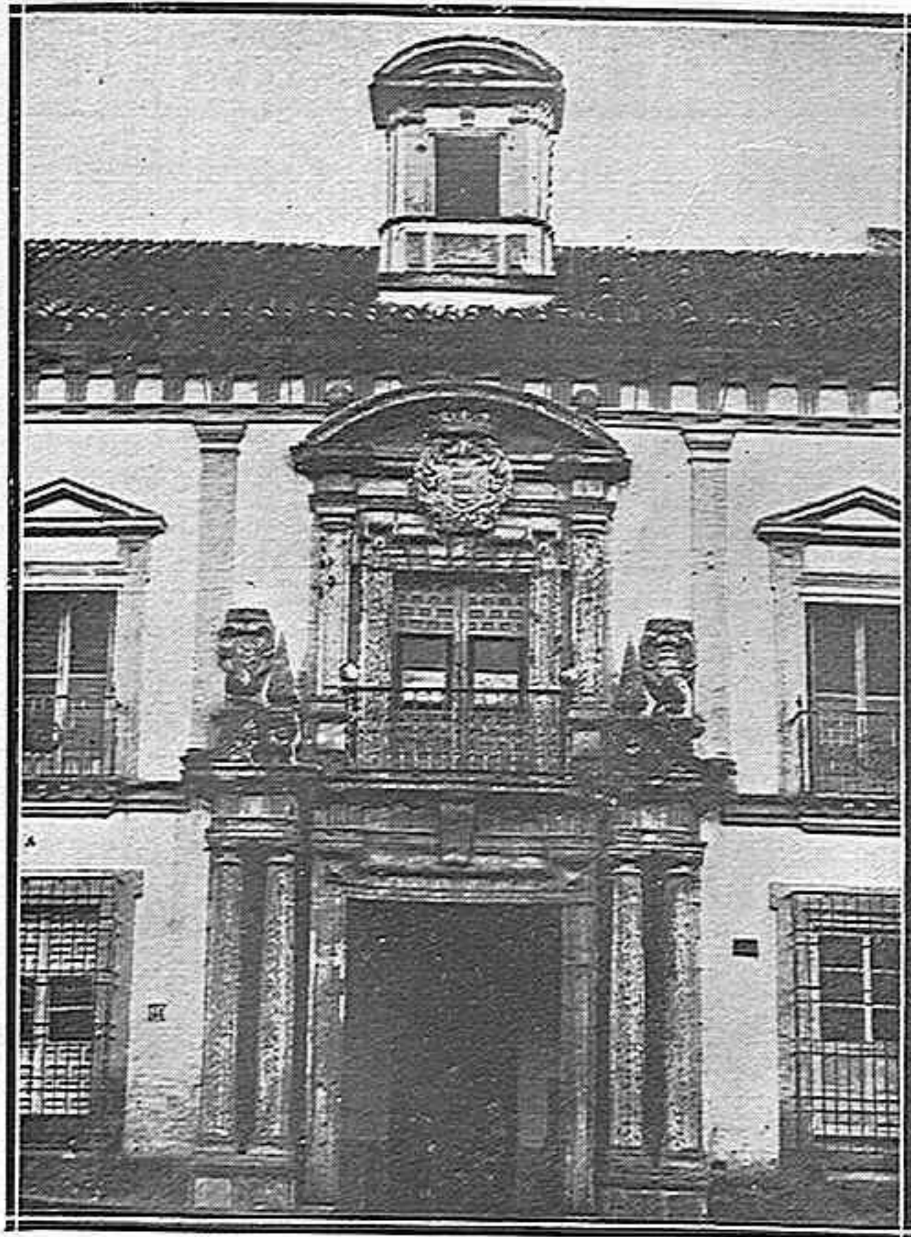
Casa de los Gutiérrez de los Ríos
