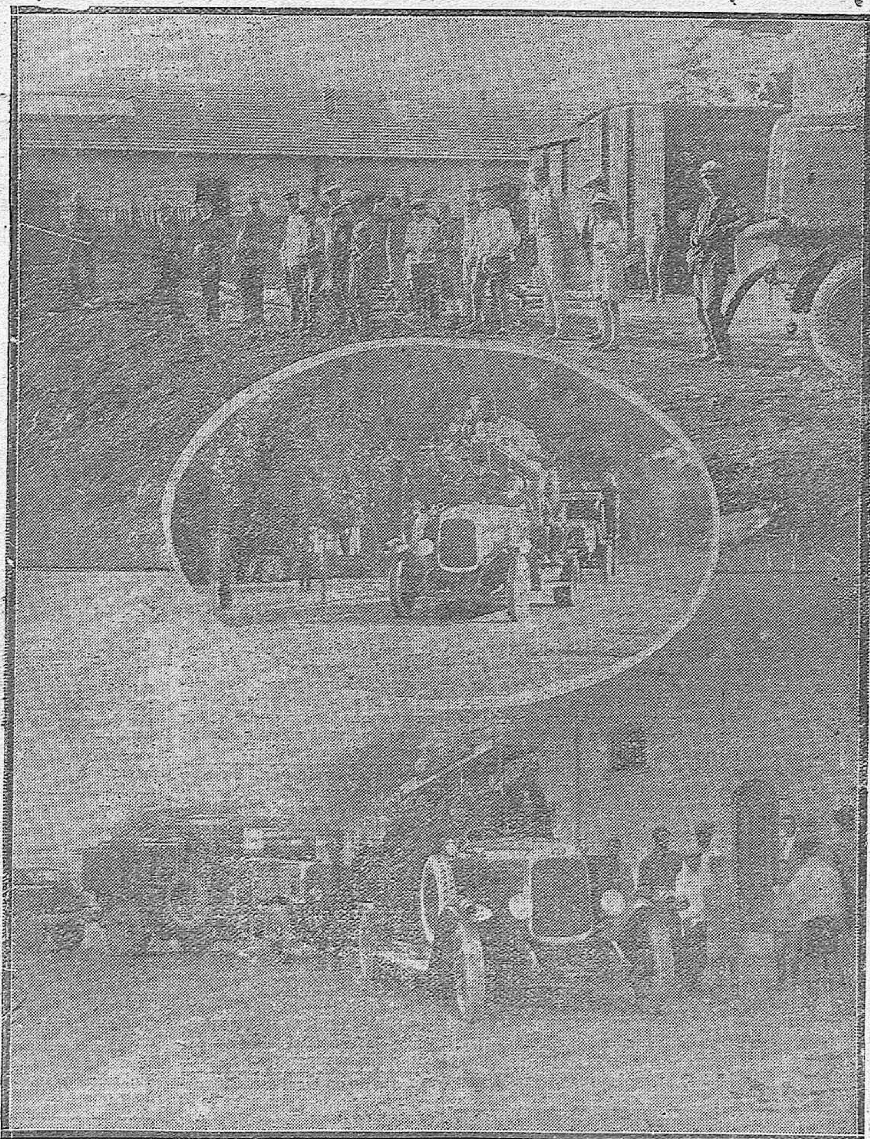
DEL FUEGO EN LA ESTACIÓN CENTRAL.—Los bomberos combatiendo el voraz elemento.—Llegada de los autos y tanques del Parque al Muelle de gran velocidad a los cuatro minutos de iniciarse el fuego.—En óvalo: El activo personal con su Jefe señor Gollonés dirigiéndose al lugar del siniestro.
