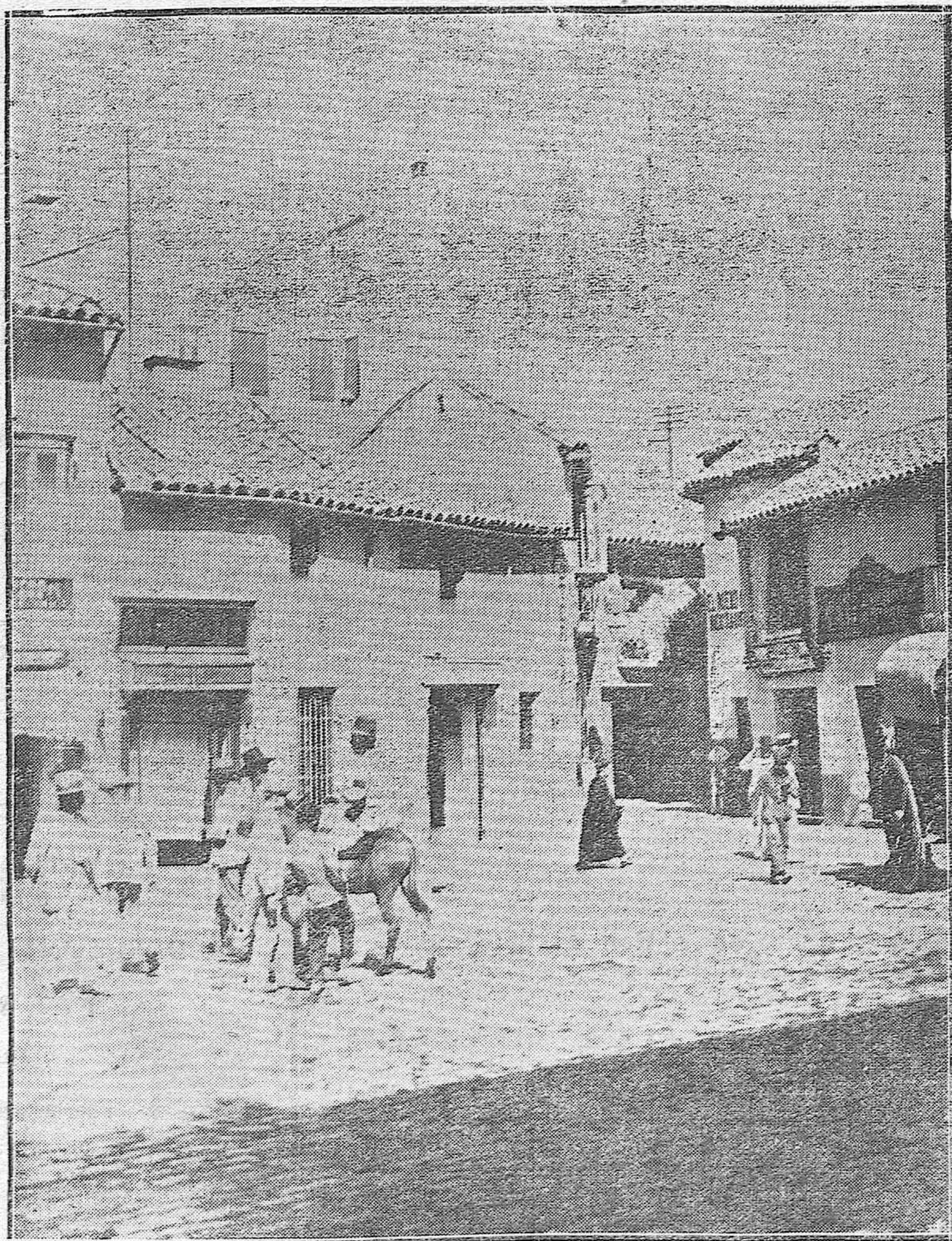
CORDOBA.—PARTE DE "LAS FENDILLAS" QUE POR ACUERDO ADOPTADO AYER POR NUESTRO AYUNTAMIENTO, SERÁ DERRIBADA PARA ABRIR UNA AMPLIA CALLE.
