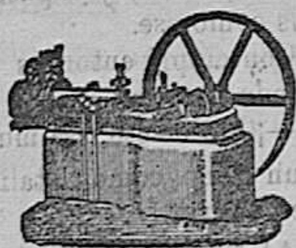
Máquina de vapor Horizontal.
