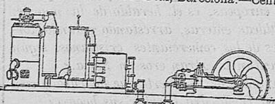
Legítimos motores Groseley y para gas pobre, petróleo, alcohol, etc. de todas potencias.—Gasógenos sistema Grossley, sin gasómetro ni caldera.—Gasógenos sistema «Dowson».—Calderas y máquinas de vapor «Davey Paxman y Camp».—Instalaciones completas de alumbrado eléctrico, transporte de fuerza, tracción eléctrica.—Bombas centrifugas.—Bombas Blake.
