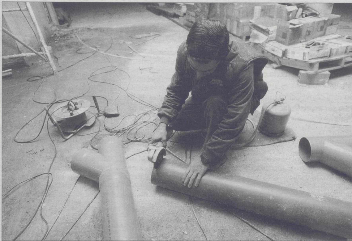
Un fontanero trabaja en una obra en construcción. / M.A.V.
