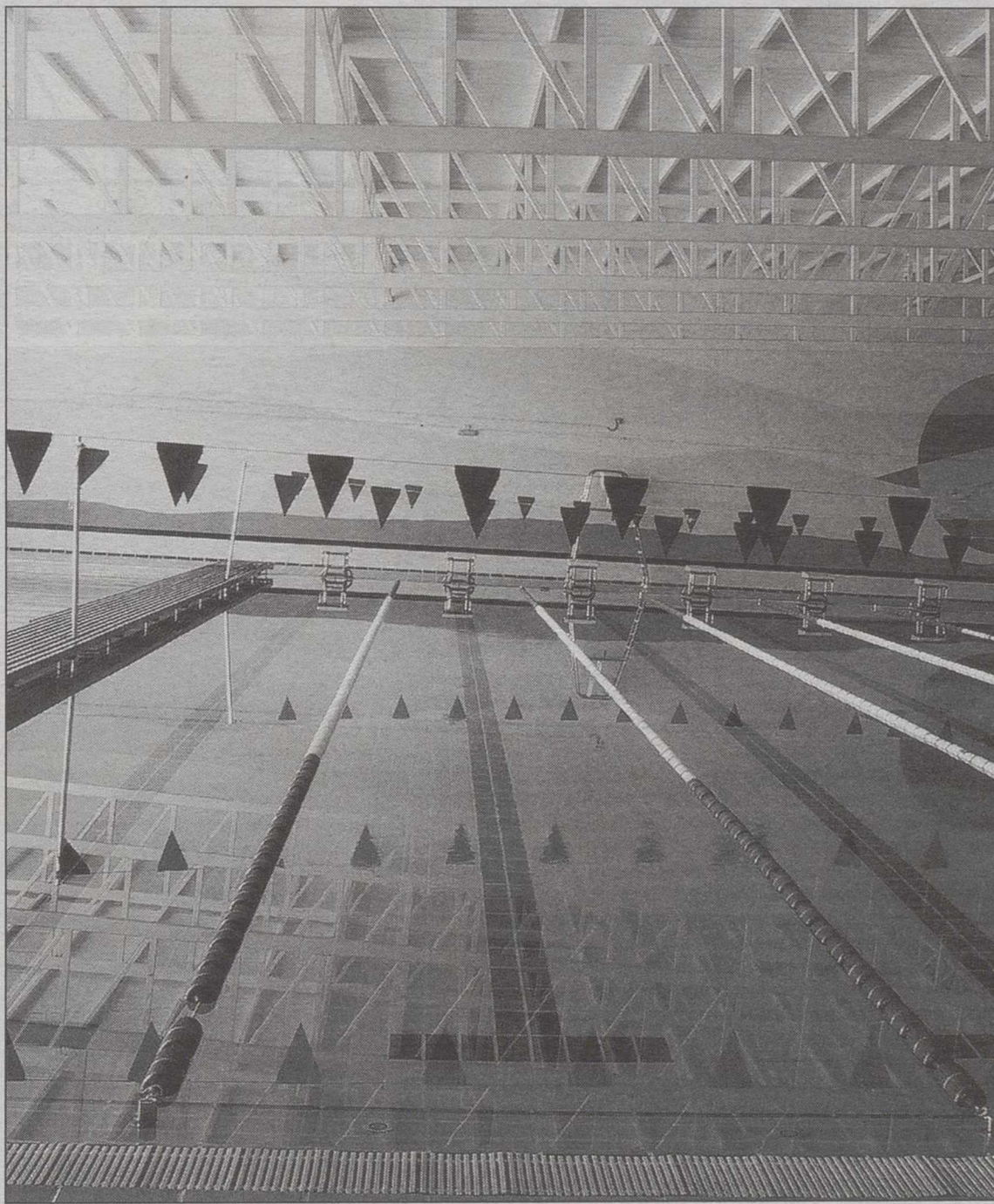
Instalaciones de la piscina climatizada de Villarrobledo.
