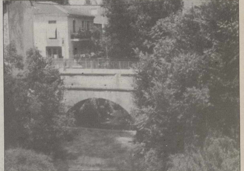
En Salobre se prolongarán las redes de alcantarillado.
