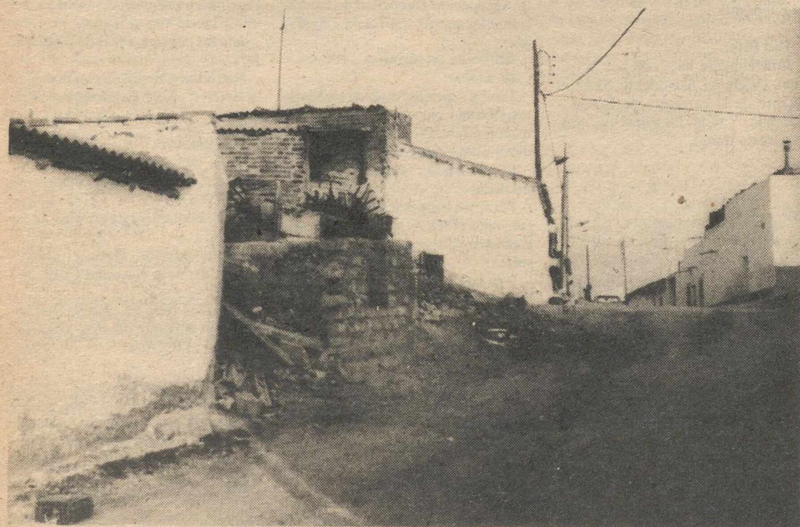
Como puede apreciarse en la foto, algunas zonas del barrio se encuentran muy deterioradas.
