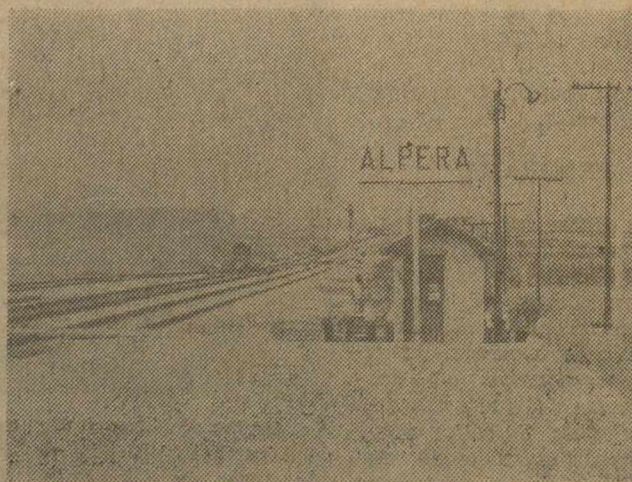
La estación de Alpera, cuartel general de las obras que ayer fueron inauguradas.
