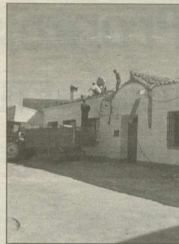
Inicio de las obras
