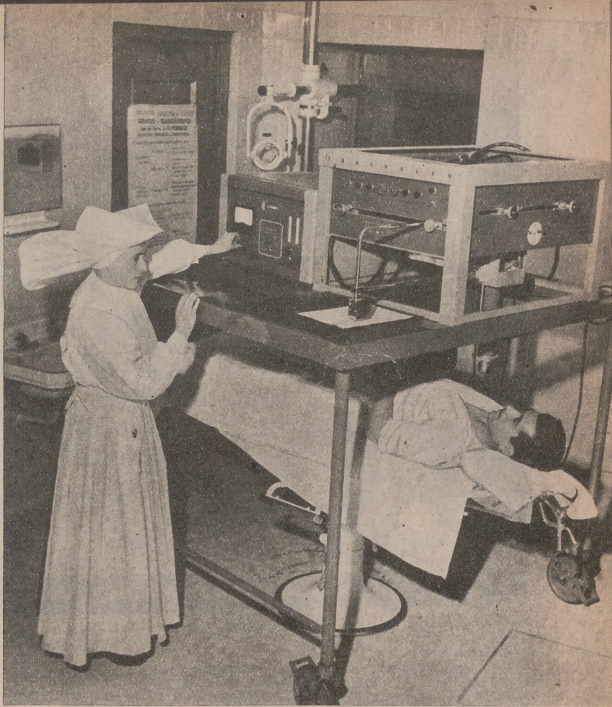
Trace-Scanner para detección de metástasis cancerosas en el organismo después de la administración de isótopos radiactivos como elementos trazadores
