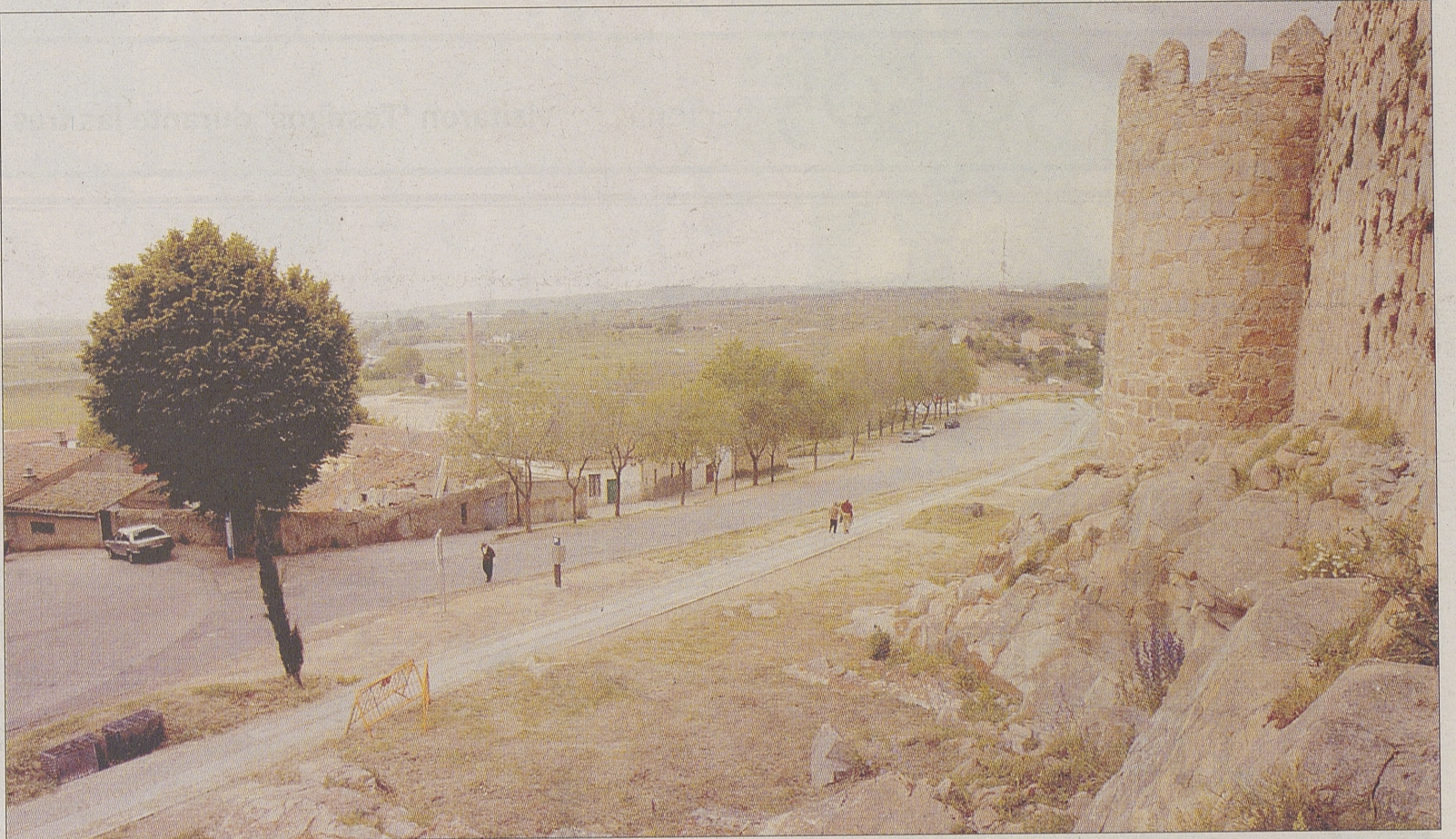
La escasa utilización del aparcamiento del Atrio de San Isidro ha llevado a su cierre provisional. / DAVID CASTRO
