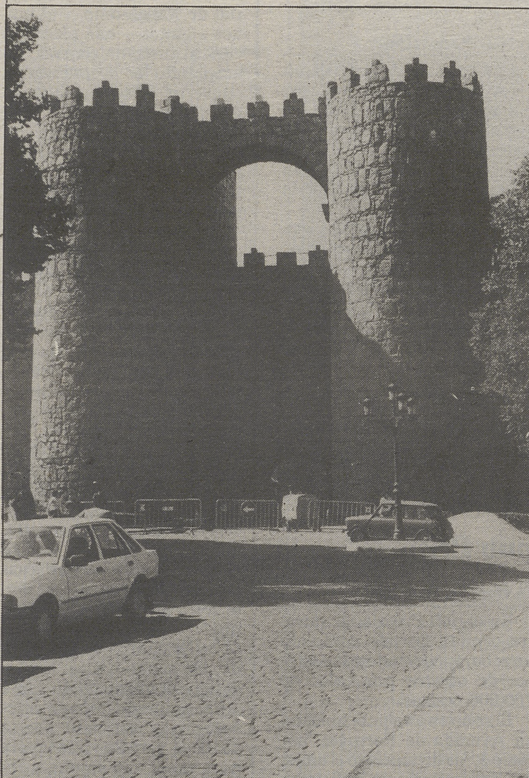
La circulación ha sido cortada en la entrada por el arco de San Vicente.
