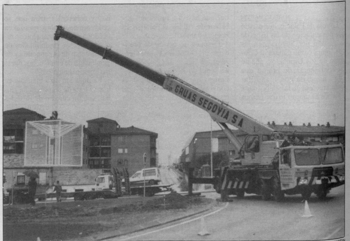
Ayer por la mañana se procedió a la colocación del monolito en una rotonda de la carretera de La Granja.
