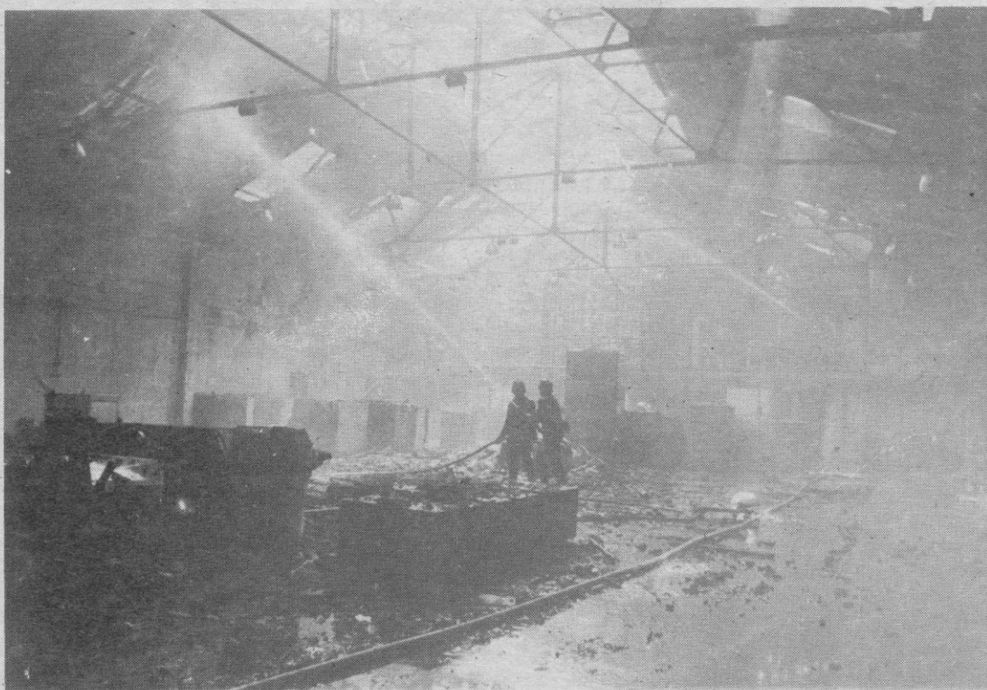
Un incendio de considerables dimensiones destruyó esta mañana una de las naves que la compañía «General Eléctrica» tiene en la calle Dr. Esquerdo, 187. El fuego se inició en una cabina de pintura, propagándose posteriormente a una nave contigua de aparatos de clínica y material de electro-medicina, resultando varias máquinas dañadas. Cuatro coches del Parque de Bomberos intervinieron en la extinción del fuego.—(Foto EFE).
