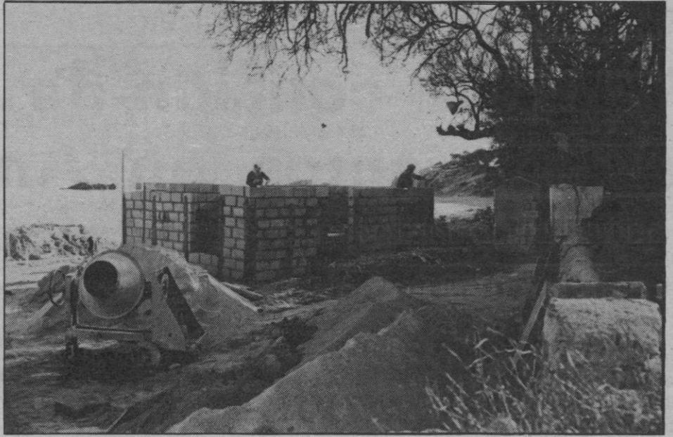
Paralizada de momento la construcción de un bar en la playa
