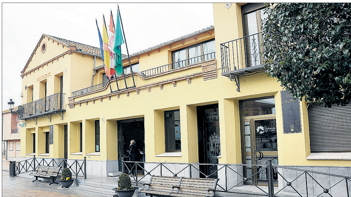
Imagen de la fachada del Ayuntamiento de Valverde del Majano. / KAMARERO
