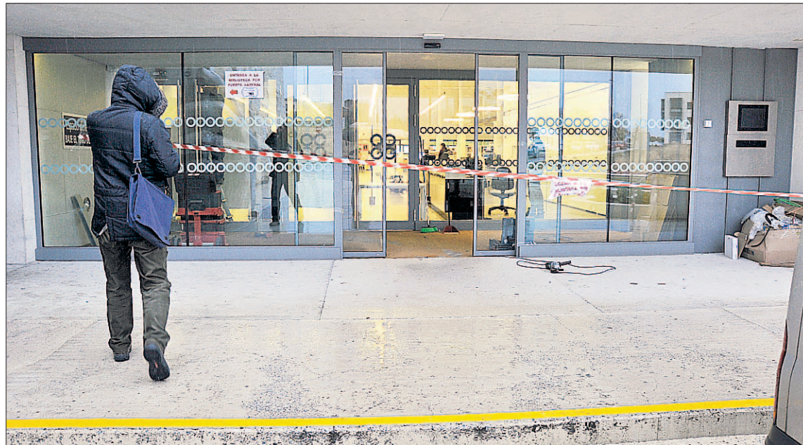
Las obras en las puertas principales de la Biblioteca de Segovia se llevan a cabo durante estos días. / KAMARERO
