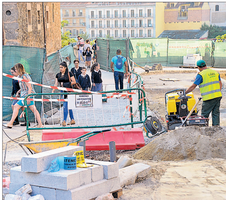
Los estudiantes y otros ciudadanos pasando junto a las obras. / KAMARERO
