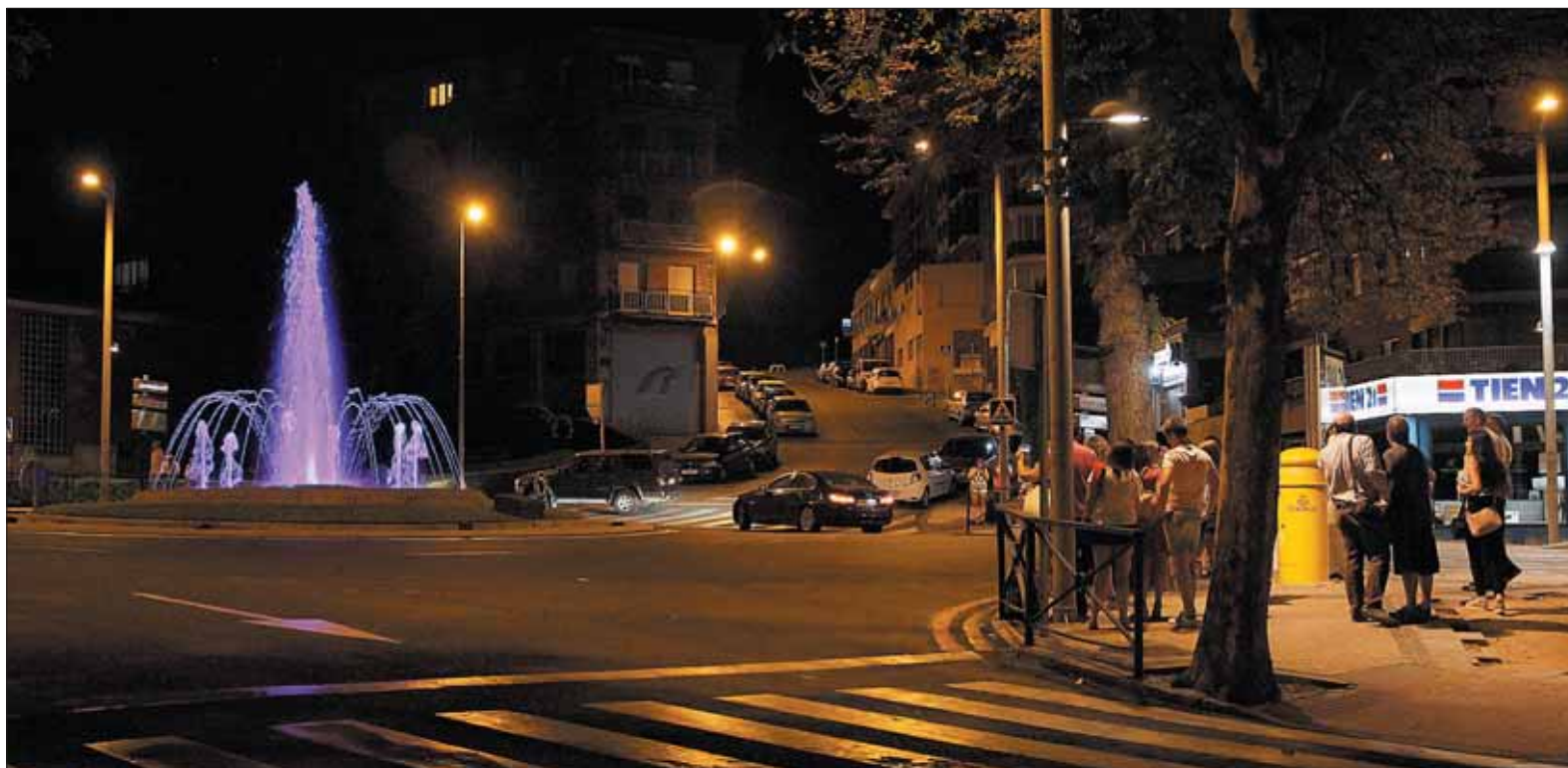
Los principales elementos de la fuente ornamental de la Glorieta del Voluntariado han tenido que renovarse e incorporar proyectores LED. / NEREA LLORENTE
