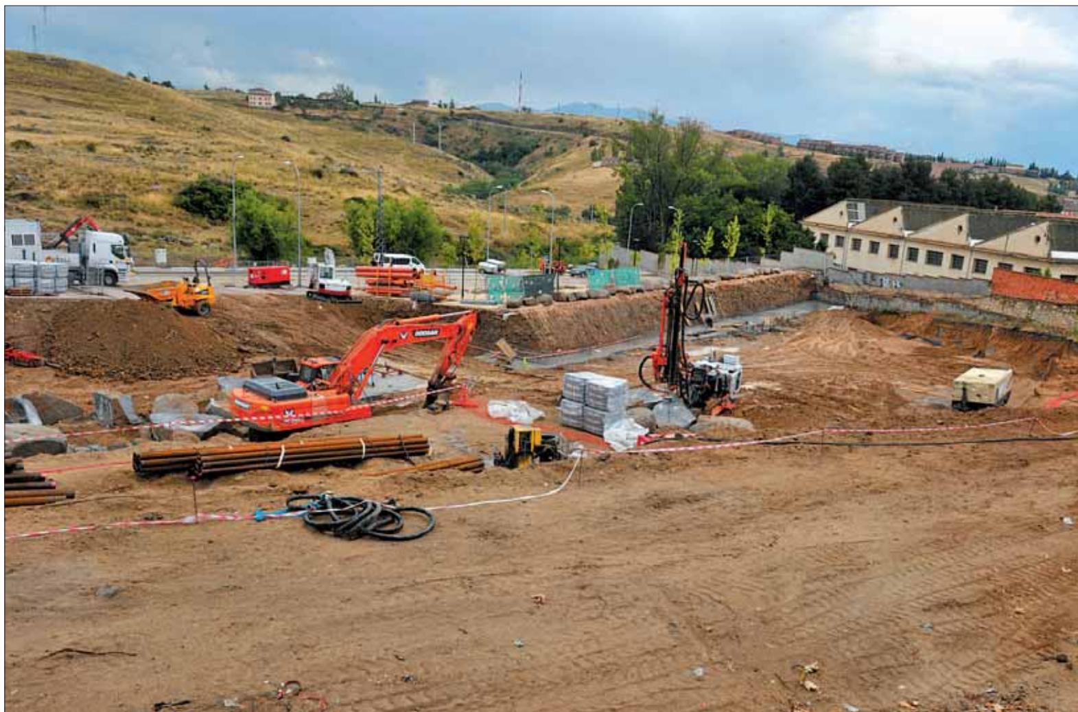
Mercadona podrá simultanear la construcción de nuevo supermercado con las obras de urbanización que ya se están ejecutando en los terrenos. / KAMARERO
