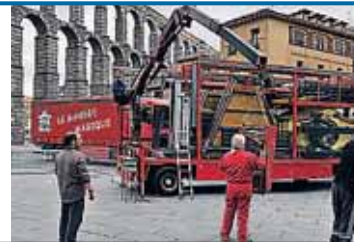
Momento de la instalación de uno de los carruseles
